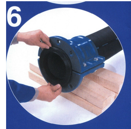
Dichtung in die Stirnfläche einlegen und Armatur endmontieren
